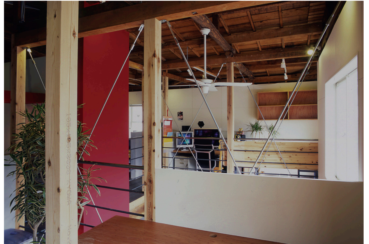
鉄とモルタル、そして木材をバランスよく取り入れ、それぞれの素材感を活かした。広々としたスペースにするため内壁を腰壁にしている
